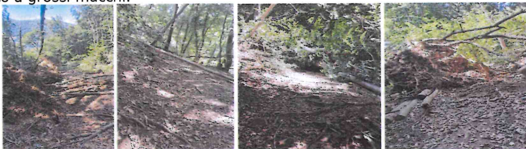
Didascalìa: immagini dei danneggiamenti provocati lungo il sentiero.
